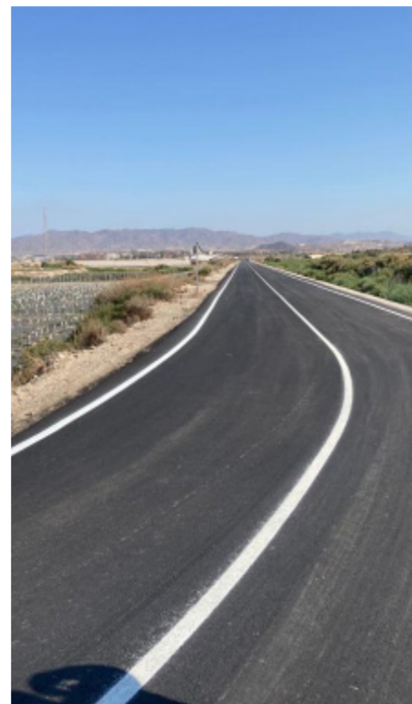
El asfaltado mejora el tránsito en esta vía
