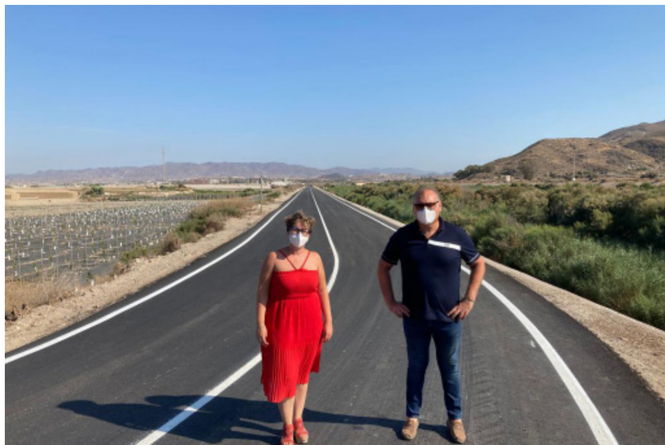
El alcalde Antonio Fernández y la alcaldesa de Palomares Maribel Alarcón comprobaron el resultado de las obras
